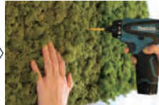
step4 パネルをビスで固定する *ビスでモスを巻き込まないように注意してください
